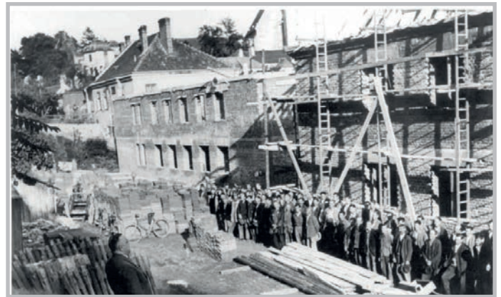
Gleichenfeier Alauntalstraße 14 u. 16, 18 (nicht im Bild) am 7.9.1938
