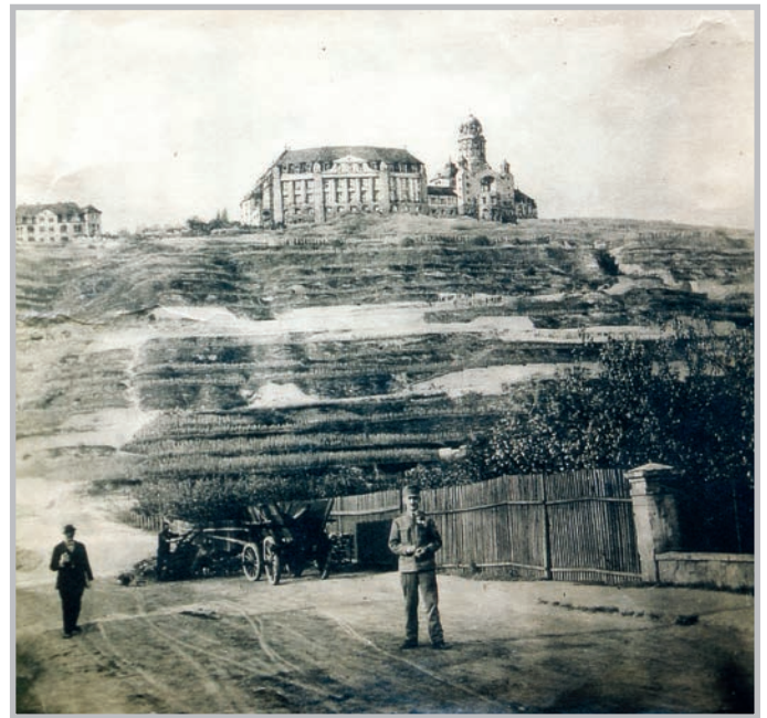
Ansicht von der Gaswerkergasse
