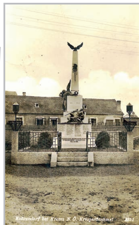
Kriegerdenkmal in Unter-Rohrendorf 1921.
