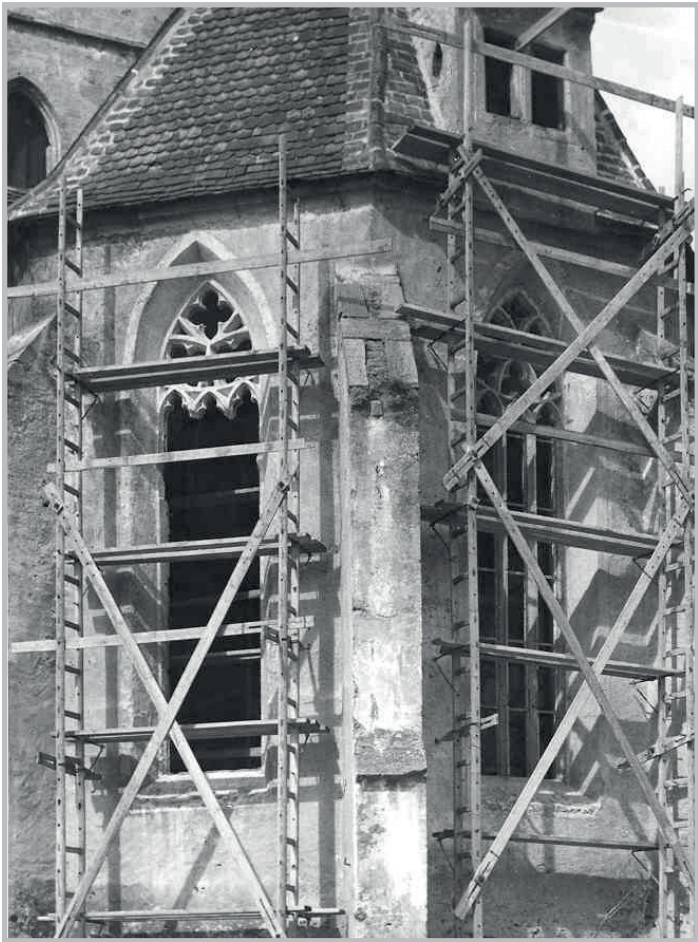
Die Gerüste der Kirche innen und außen.
