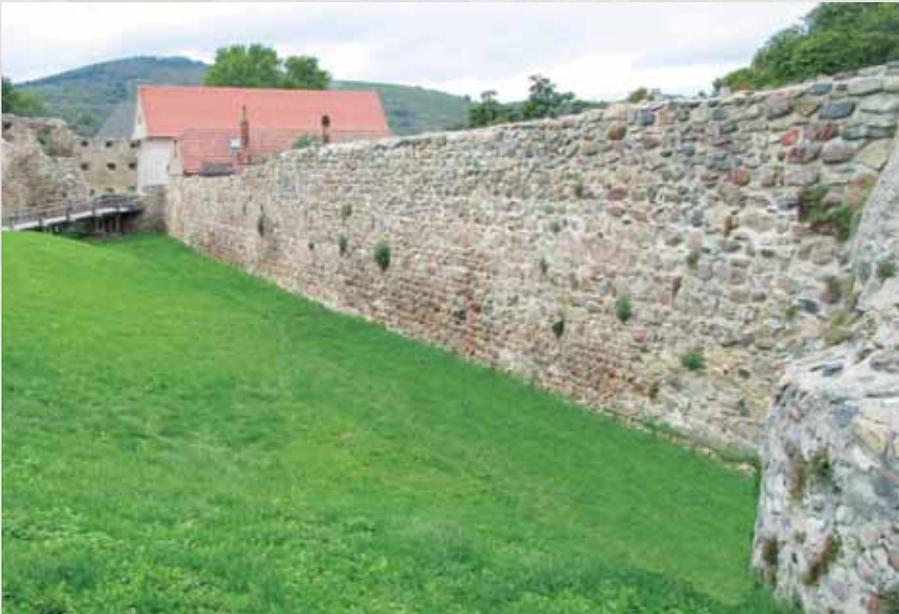
Eine einwandfreie Datierung der Mauer ist jedoch nicht möglich, da das gleiche Material später für Erweiterungen und Ausbesserungen verwendet wurde. In mehreren Bauphasen wurde das Mauerwerk auf eine Höhe von mehreren Metern hochgezogen. Das ist an den Balkenlöchern erkennbar, die für den Aufbau benötigt wurden.
