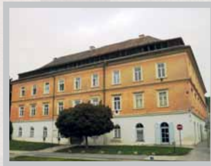
Die ehem. Landwehr-Kaserne im Jahr 2013
